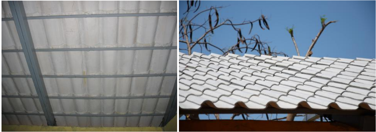
Cubierta de TMC en la Comunidad El Triunfo (Champerico, Guatemala) del Proyecto de ASF-Galicia-ASIAPRODI
