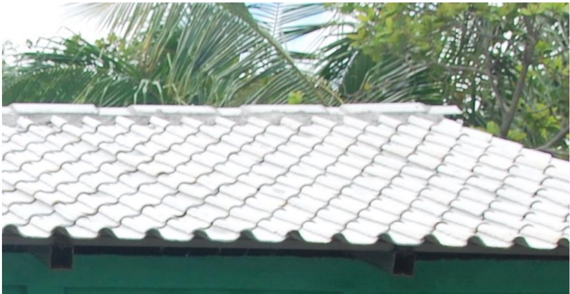
Cumbrera de una obra de mejora de techo mínimo realizada por ASF-ASIAPRODI en el Programa Oxlajuj Tz'ikin
