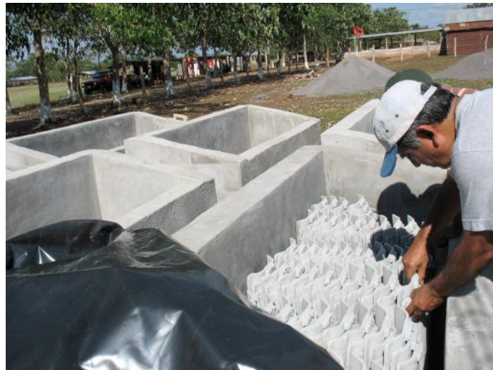
Operario colocando tejas para su curado
